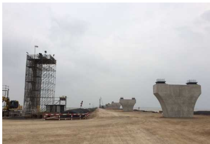
ラックフェン国際港建設計画(道路橋梁)
