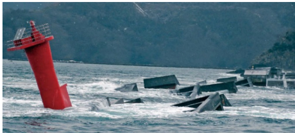
2011年東北地方太平洋沖地震・津波による釜石湾港防波堤の被災
